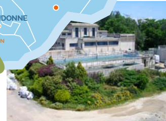
Ressource superficielle Station de traitement Pont de Durance
